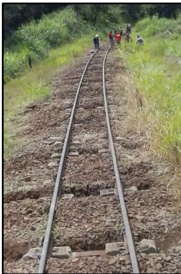
Substituição de dormentes no km 11. Fotos: Hélio Gazetta Filho.
