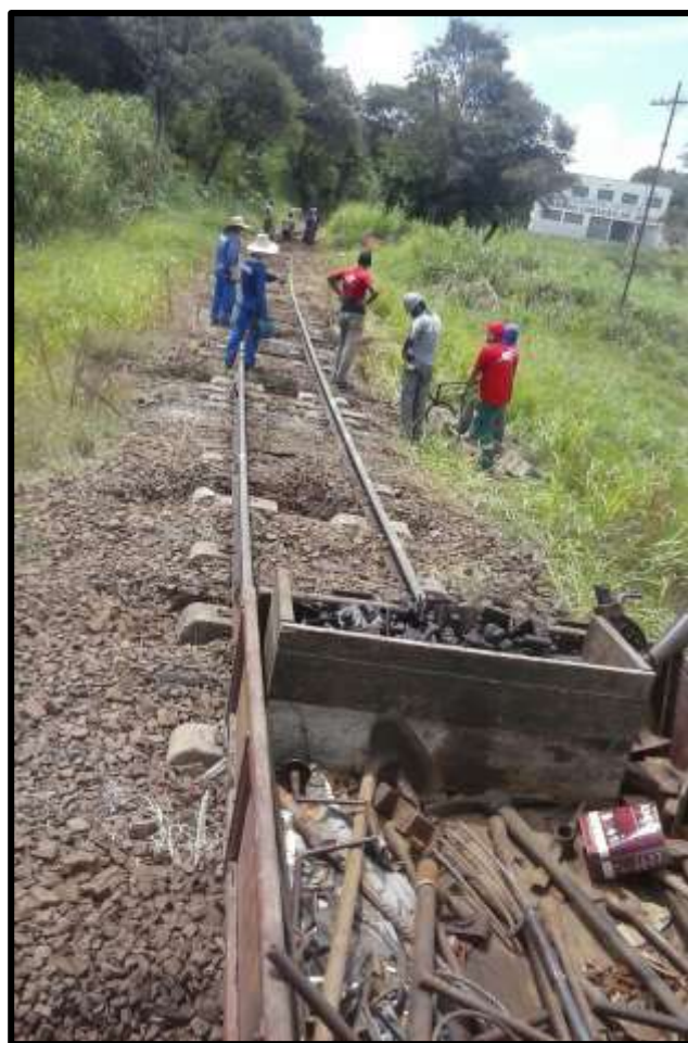
Substituição de dormentes no km 11. Fotos: Hélio Gazetta Filho.
