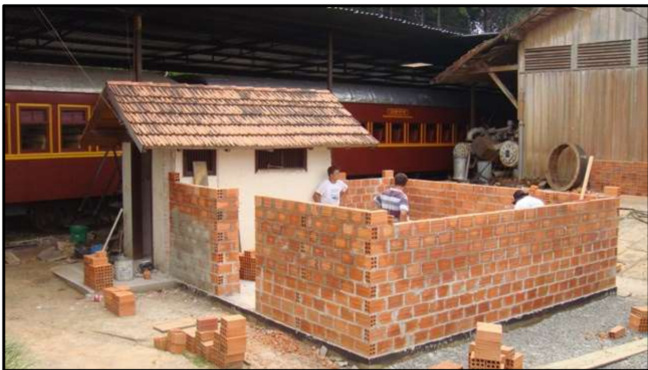
Levantando as paredes do novo sanitário.
