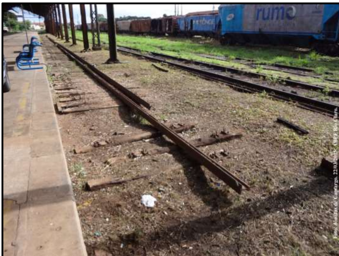
Acima: aspectos do local em 22 de março com parte dos trilhos já pré-posicionados para fixação. Abaixo: primeiros 100 metros de linha instalados em dois de abril de 2015.
